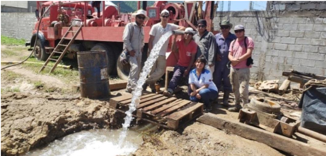
Figura 6.: Pozo perforado en el Parque Industrial de Salta, extrayendo agua subterránea.
